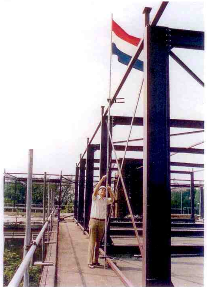
Hoogste punt bereikt, uitbreiding Kantoorgebouw en HTC.
